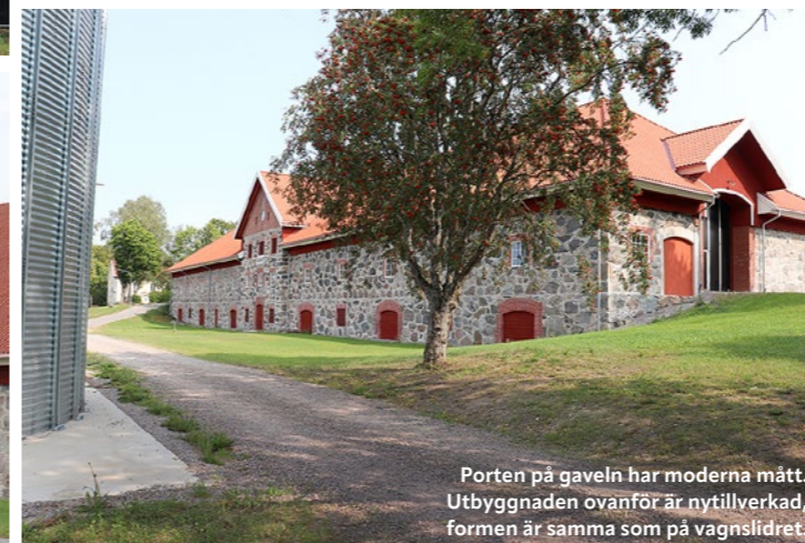
Grästensmurarna har skånsk förebild med detaljer i tegel och svarta stenar i murbruket.
