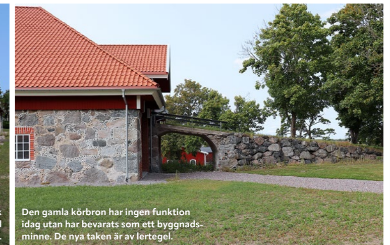
Den gamla grästensmuren är reparerad och påbyggd (det ljusa murpartiet). Utrymmet mellan muren och taket är inklätt i trä.
