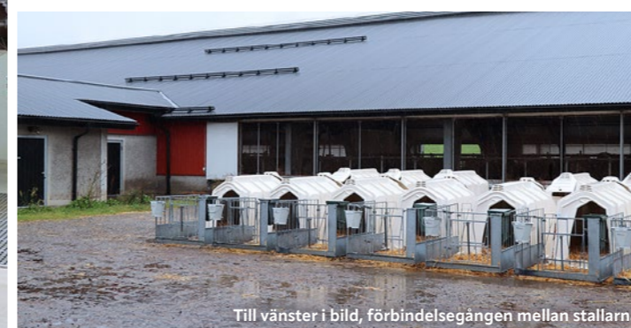
Genomgående är det betong där korna går, stål i stommar och plåt på väggar och tak. Ljusinsläpp ger en behaglig miljö.
